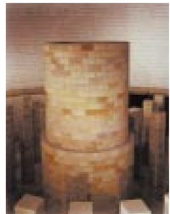
Obložení z kyselinovzdorných cihel Lining with acid resistant bricks
